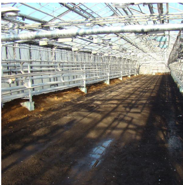
Рисунок 3.8 - Полуось теплицы после удаления санитарного слоя почвы
